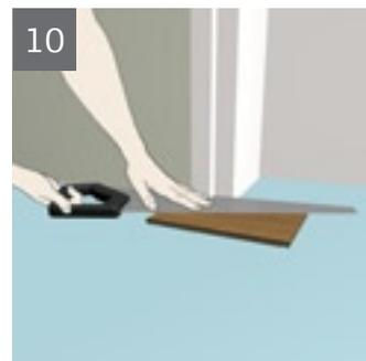
**11.** Чтобы отпилить доски последнего ряда до необходимой ширины, положите последнюю доску последнего ряда на предпоследний ряд, с припуском от стены, равным приблизительно 5 мм. Сделайте пометку на месте спила, используя обрезок доски без замка. Уложите отрезанную доску. Также поступите со следующей.
